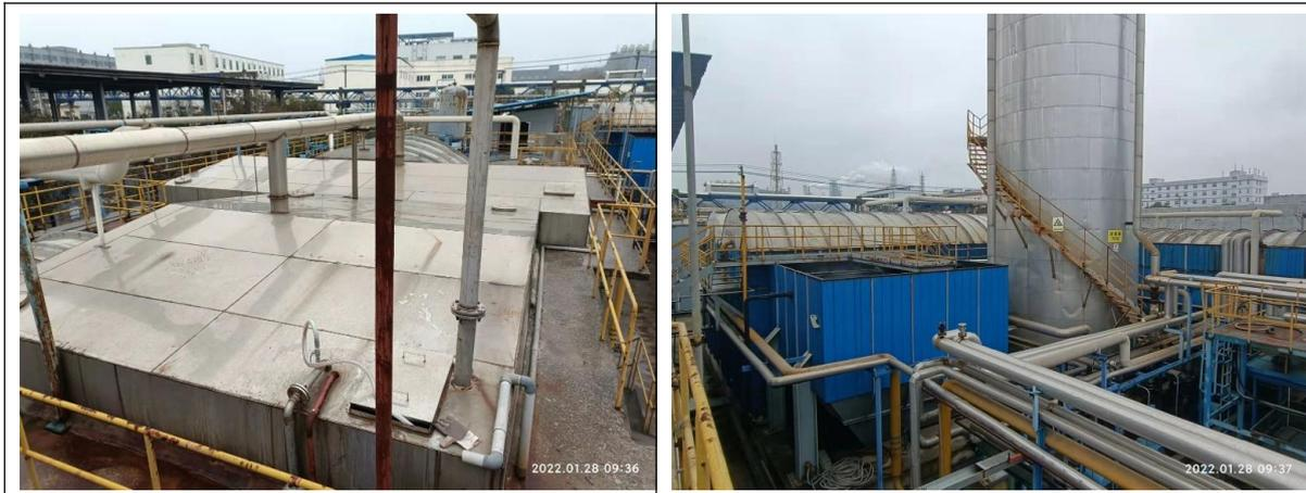
图 4.1-2 污水处理站“高负荷耗氧+接触氧化+二级生化池”
