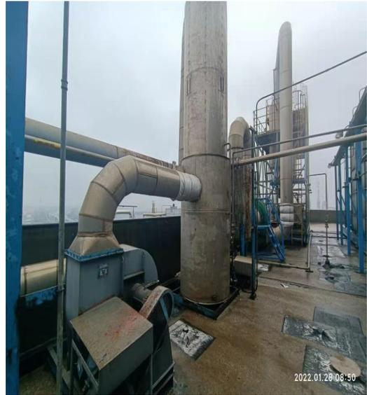
水喷淋吸收塔+超声波喷淋塔(一车间废气处理)
